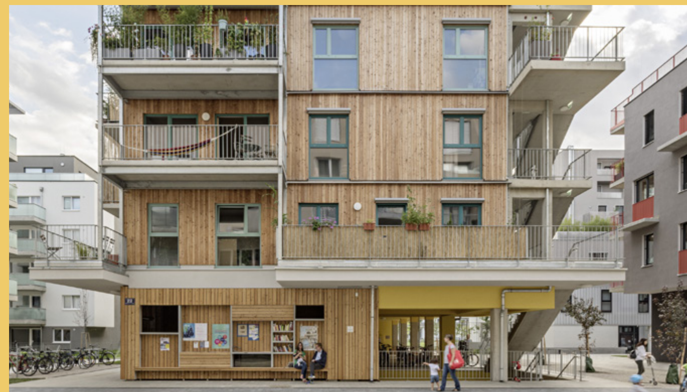
Gleis 21, fot. Hertha Hurnaus
