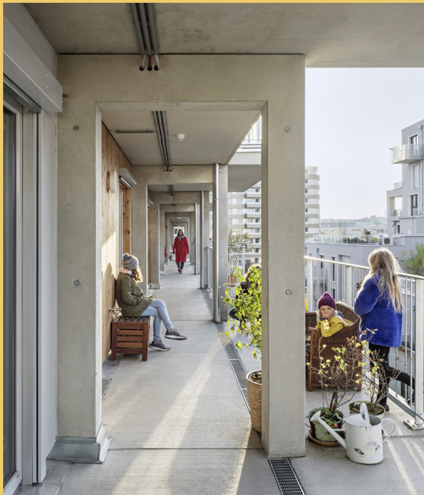
Gleis 21, fot. Hertha Hurnaus
